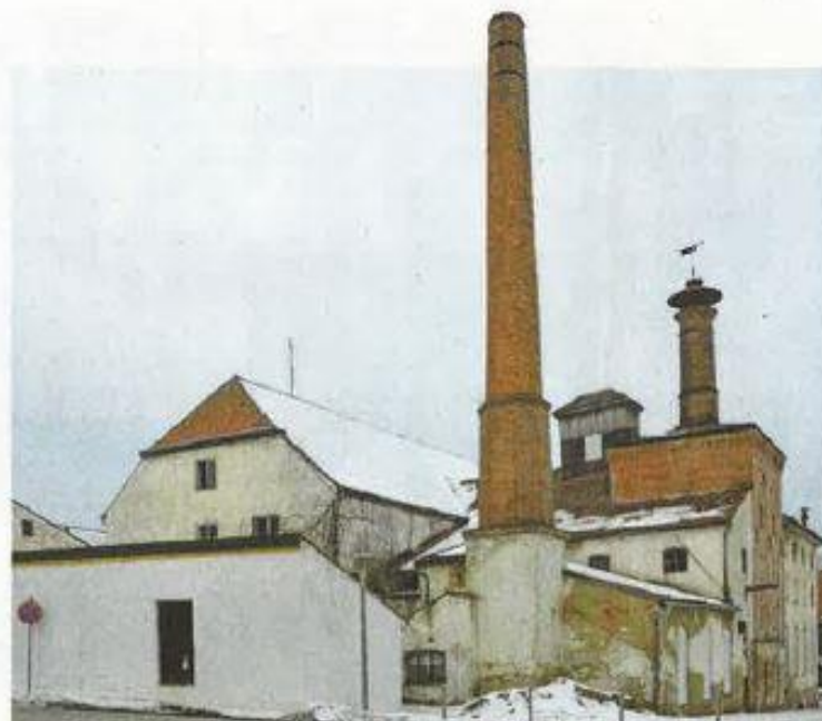
Die denkmalgeschützte Brauerei der Schlossökonomie in der Hofmark Gern soll zum virtuellen Versuchslabor revitalisiert werden. Foto: König
